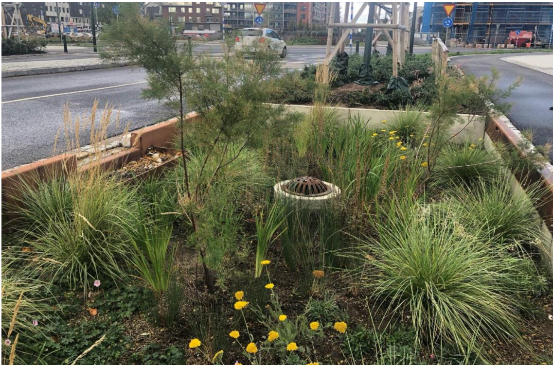
Figur 35. Nedsänkt regnbädd i anslutning till gata i Västra hamnen i Malmö (foto: Tyréns AB)
