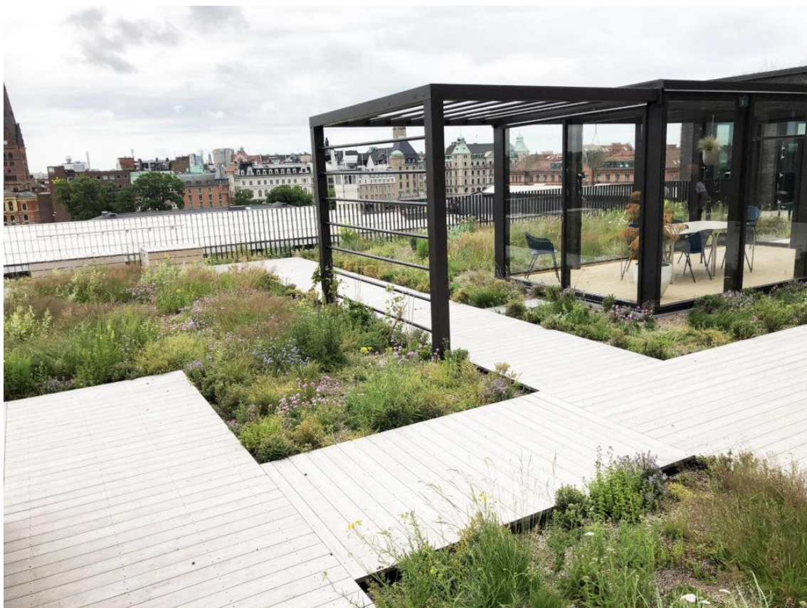
Figur 39. Takträdgård på byggnad i centrala Malmö (foto: Veg Tech)
