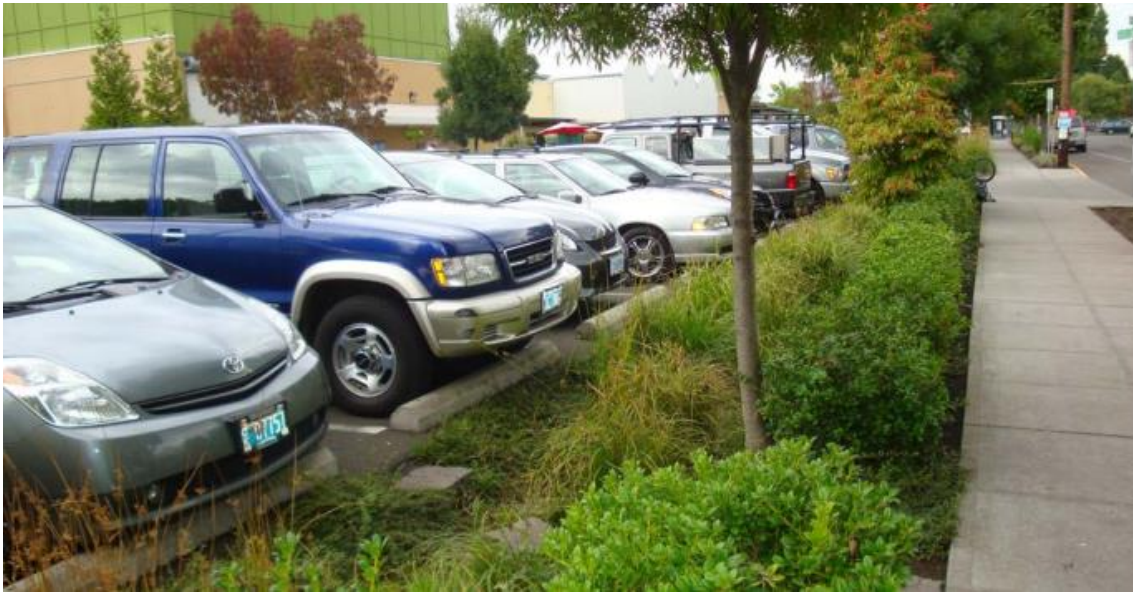
Figur 36. Regnbädd i anslutning till parkering i Portland, USA (foto: Dagvattenhantering – en exempelsamling, Uppsala kommun).
