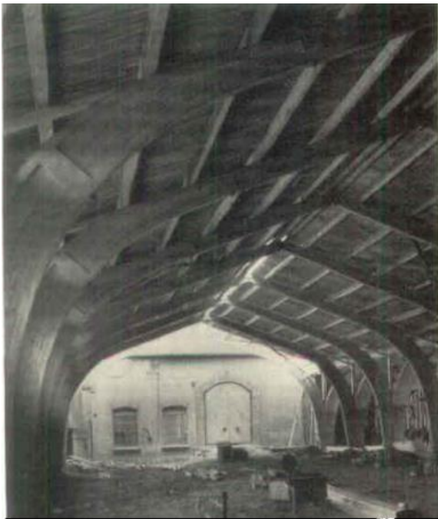
Bild från byggarbetena med de nya byggnadsvolymerna 1949. Källa: Brännpunkt nr. 4 1949
