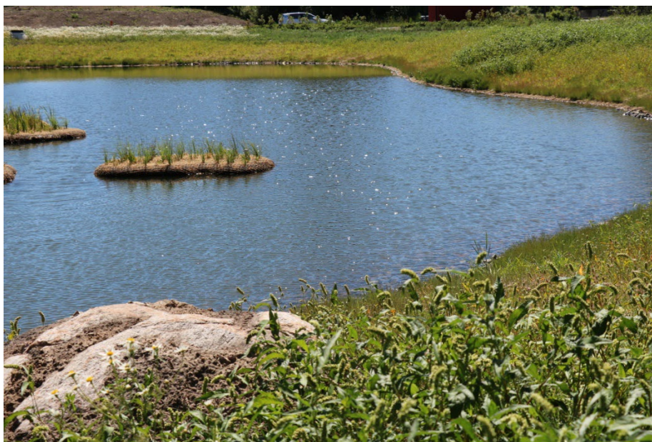
Öppet fördröjningsmagasin (damm)
