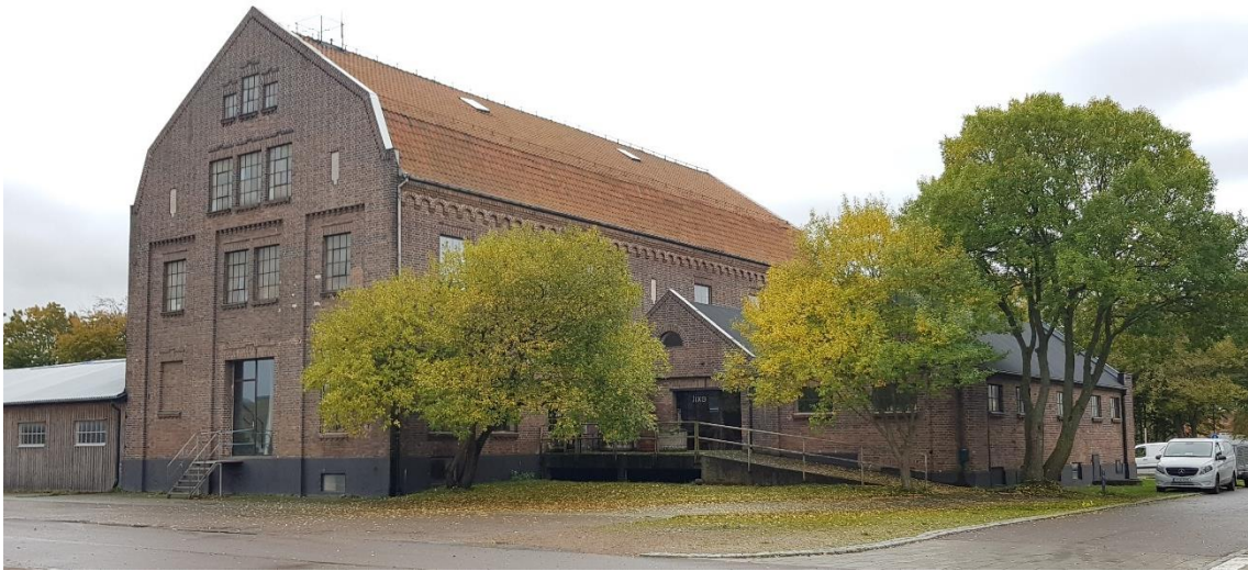
Den äldre delen av Blå ballen (det gamla centralförrådet). På bilden syns både den högre delen, med tegelbelagt mansardtak och den lägre delen med papptak.
