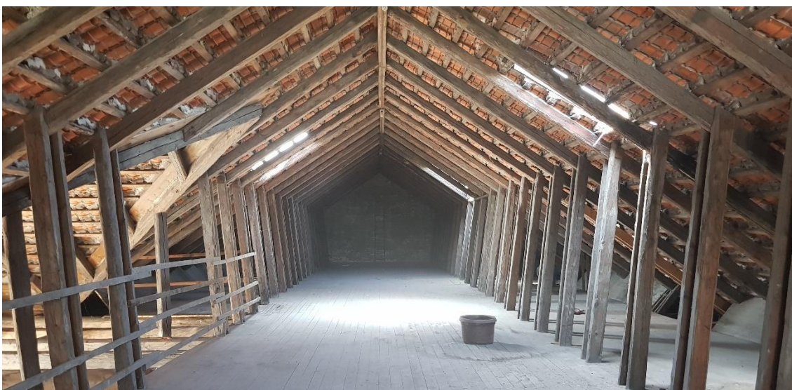
Takstolar och takpannor på öppen läkt på fjärde våningen.
