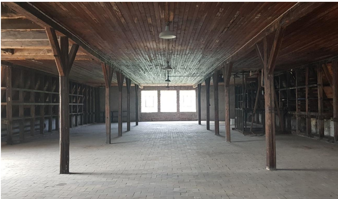
Den bärande konstruktionen på tredje våningen. Ursprungliga armaturer hänger i taket.
