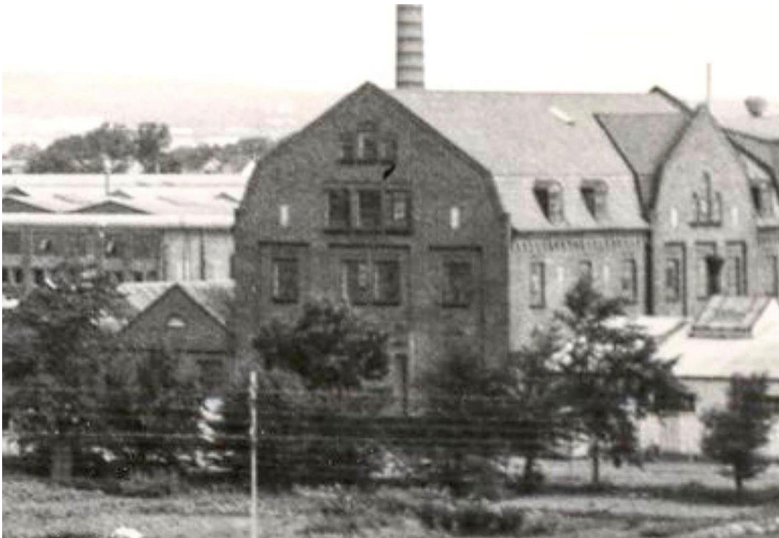
Äldre bild som visar en lanternin, eller liknande påbyggnad, på trädelsens tak. Foto från Stanfordska Sällskapet.
