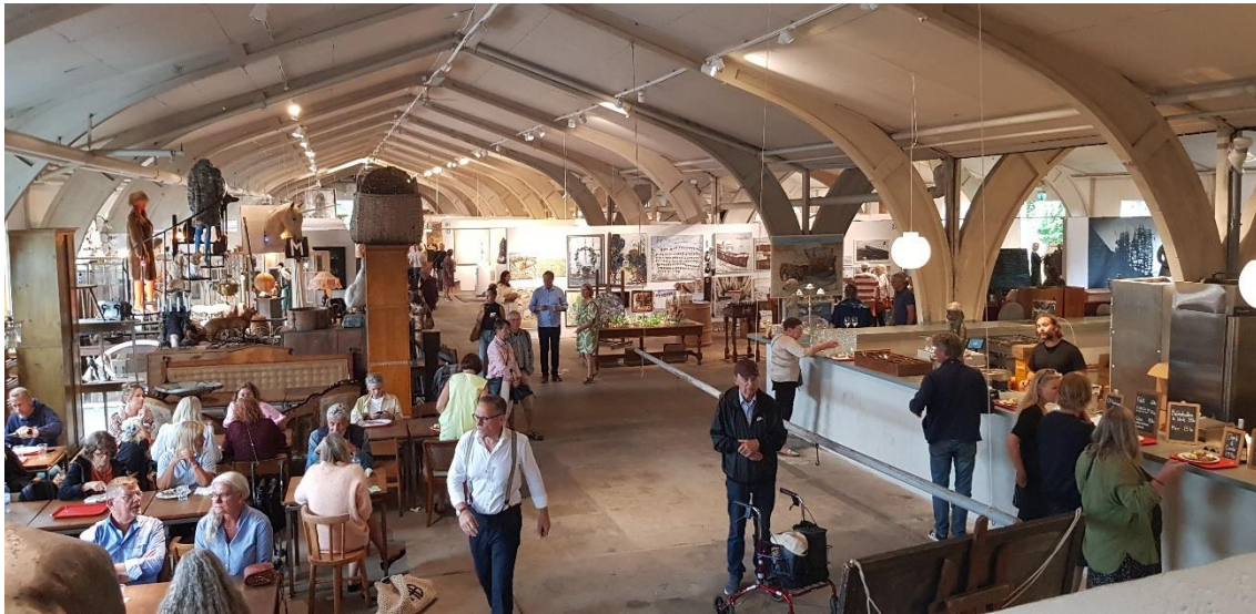
Interiör från tillbyggnaden, som visar bland annat limträstommen.
