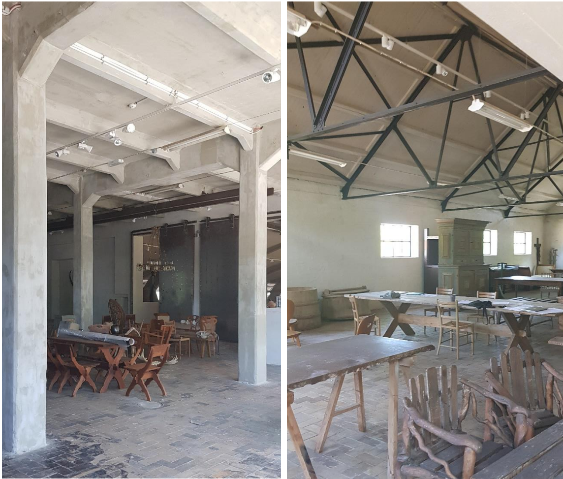
Den vänstra bilden visar konstruktionen med pelare och betongdäck. Den högra visar ståltakstolarna i den lägre delen.
