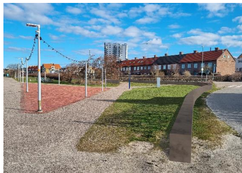
Läge B – Dansbanan vid Fortet och Krickbadets södra entré där skyddsmuren ansluter till befintliga höjder mellan +2,7 och +3,3 m.ö.h. RH 2000. Detta innebär en mur från befintlig marknivå till en höjd på ca 0,8–0,5 meter år 2150.
